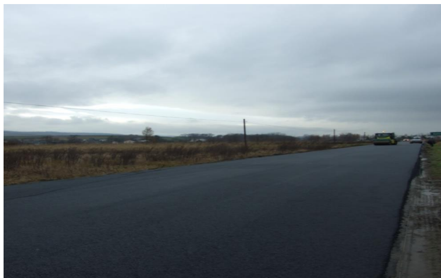
Fragment drogi w Kobylanach
