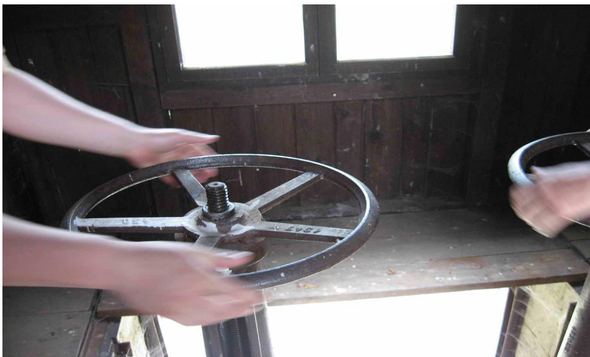
Obr. 22 Funkčnosť vypúšťacieho systému rybníka
