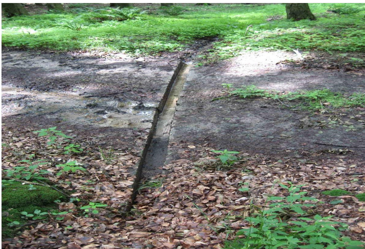
Obr. 12 Vybudované betónové odrážky na lesnej ceste
