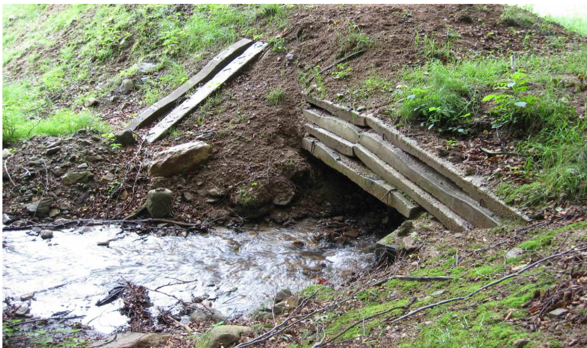
Obr. 11 Spevnenie hrádze a premostenie
