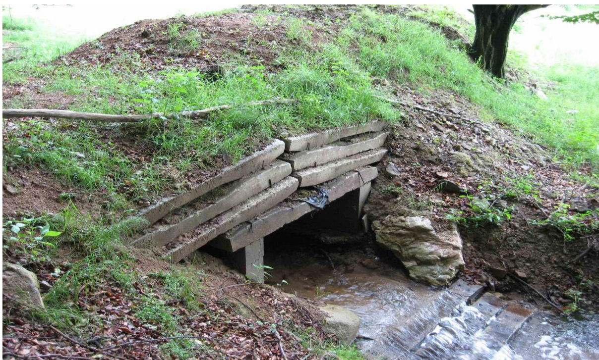
Obr. 10 Spevnenie hrádze
