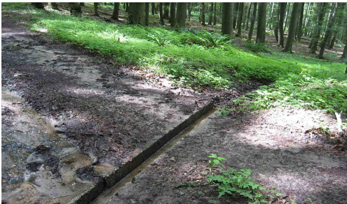
Obr. 13 Vybudované betónové odrážky na lesnej ceste
