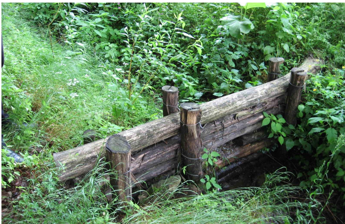
Obr. 8 Hrádzka s nasadenými vrbami na spevnenie brehov
