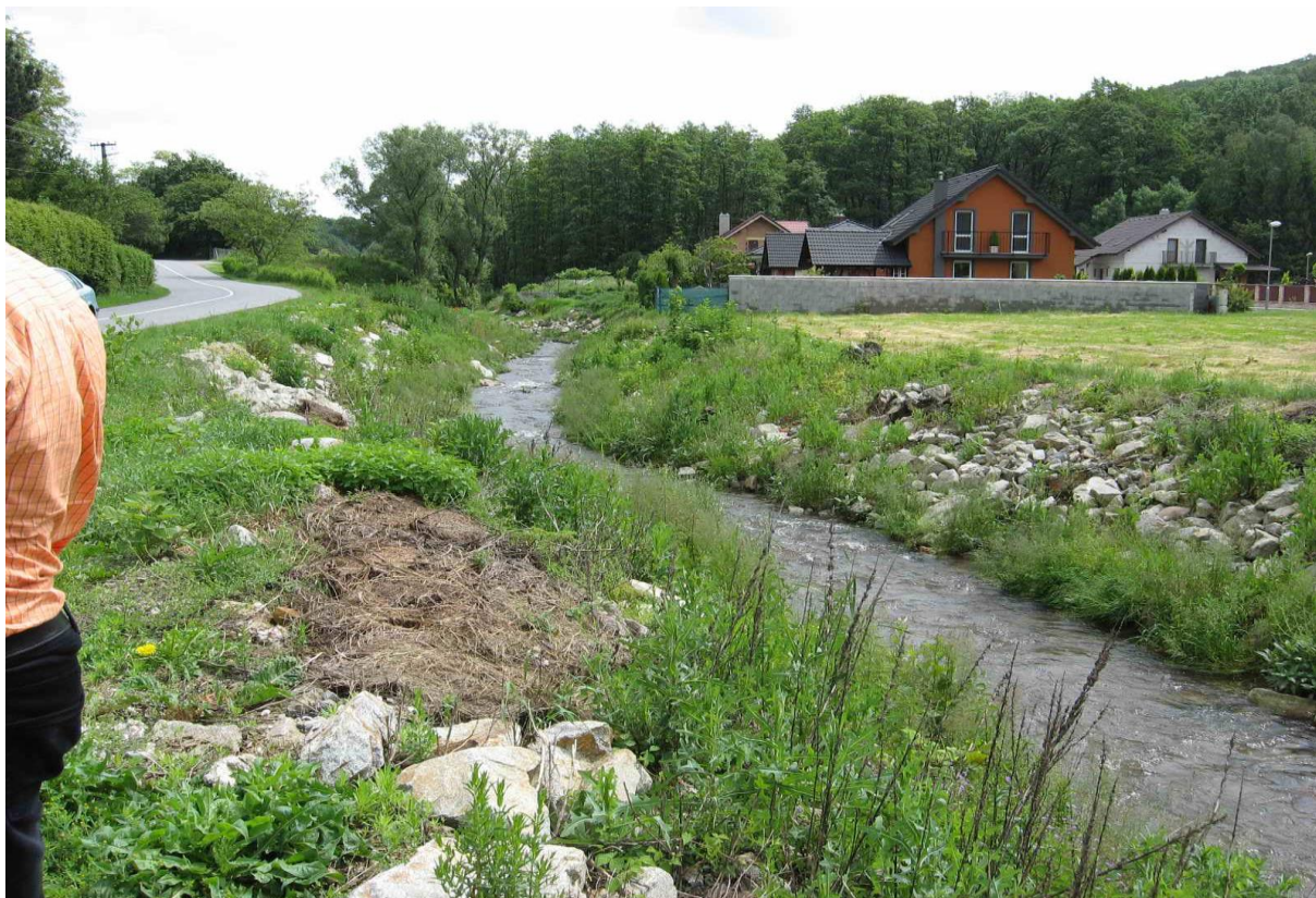
Obr. 18 Úprava a spevnenie brehov kameňmi v obci
