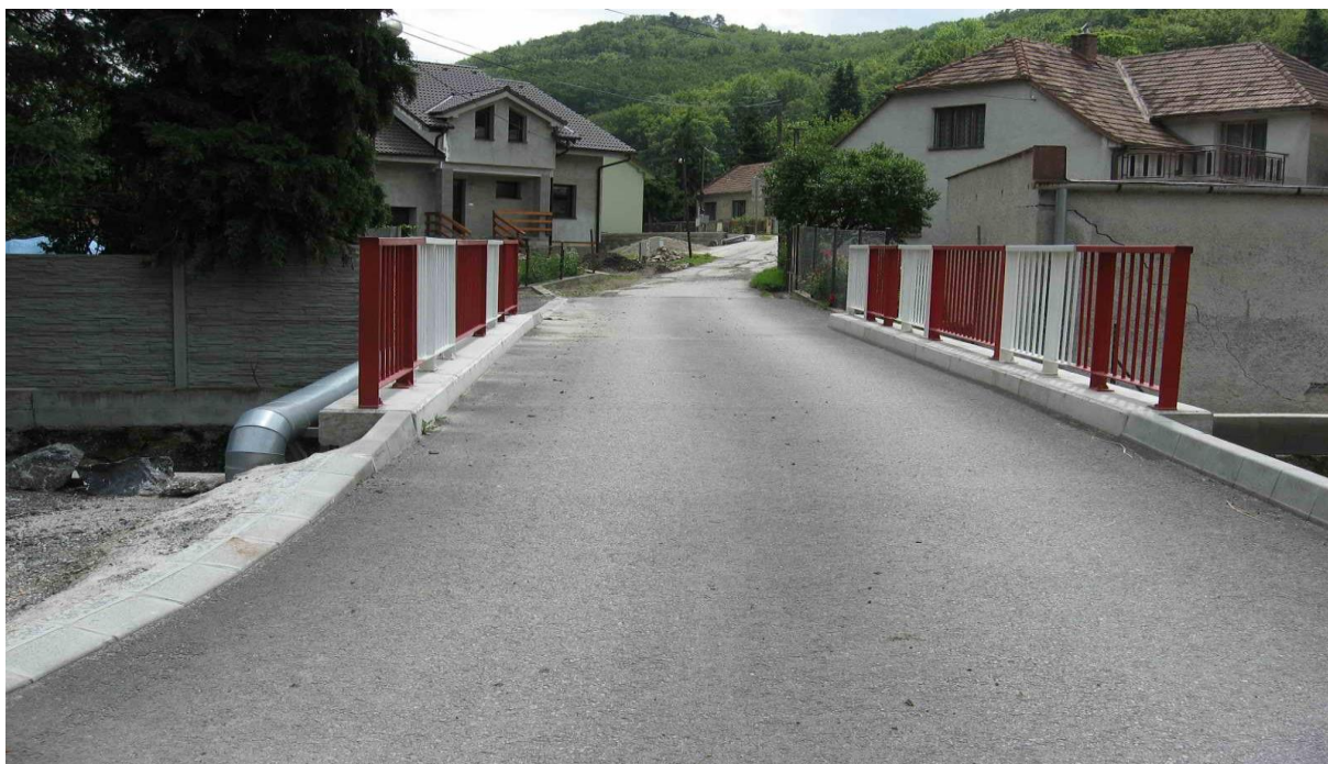
Obr. 17 Vybudované komunikácie s mostom
