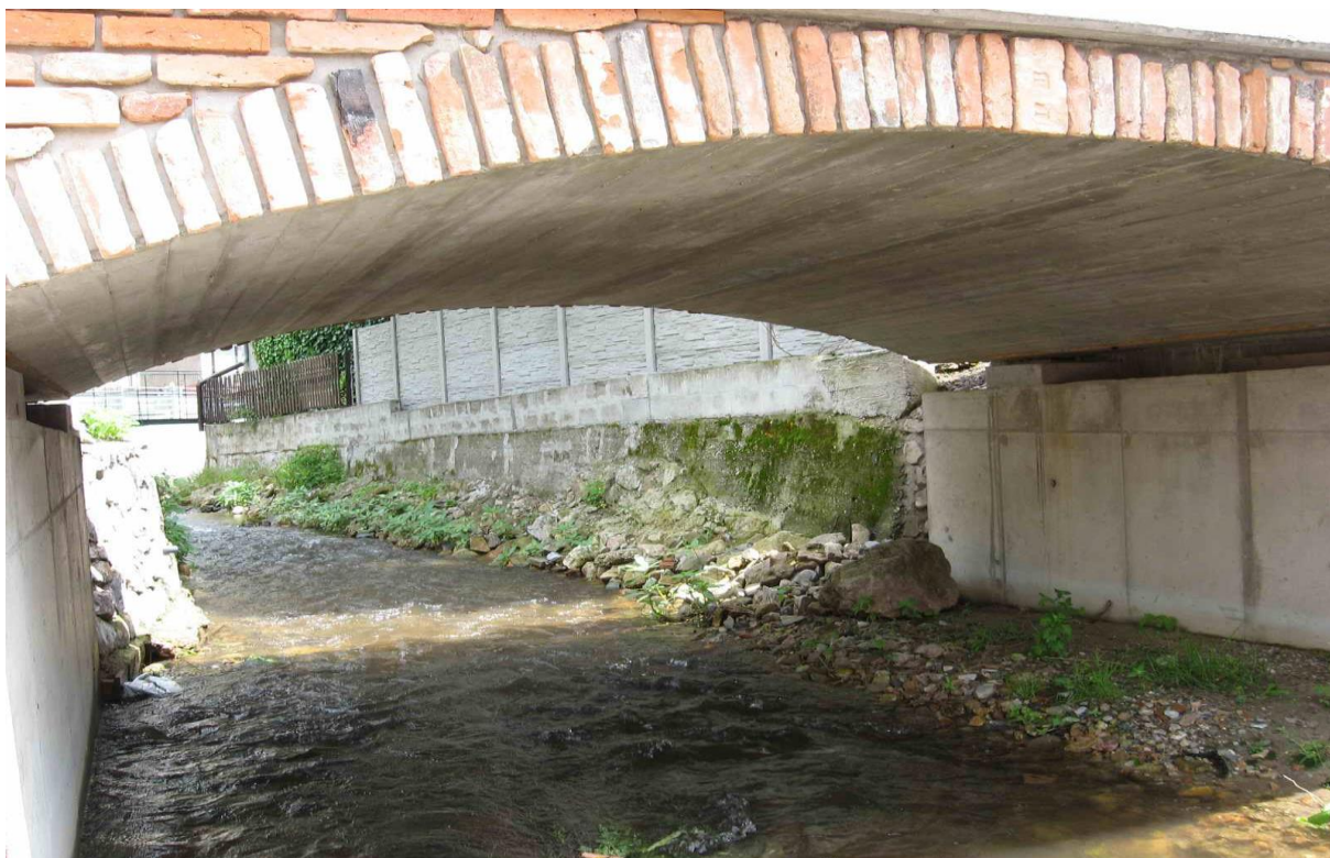
Obr. 16 Vybudovanie mosta 2 a jeho zvýšenie
