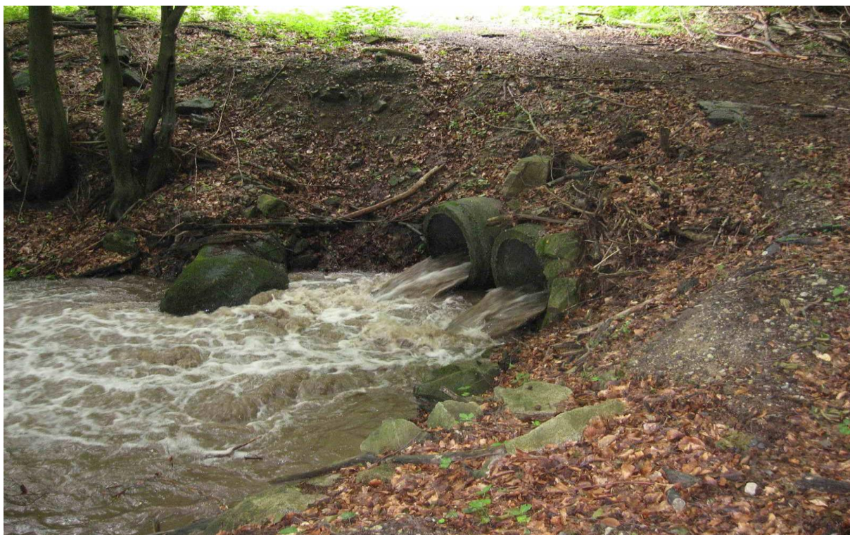
Obr. 3 Obnova prietoku vody po vyčistení náplav
