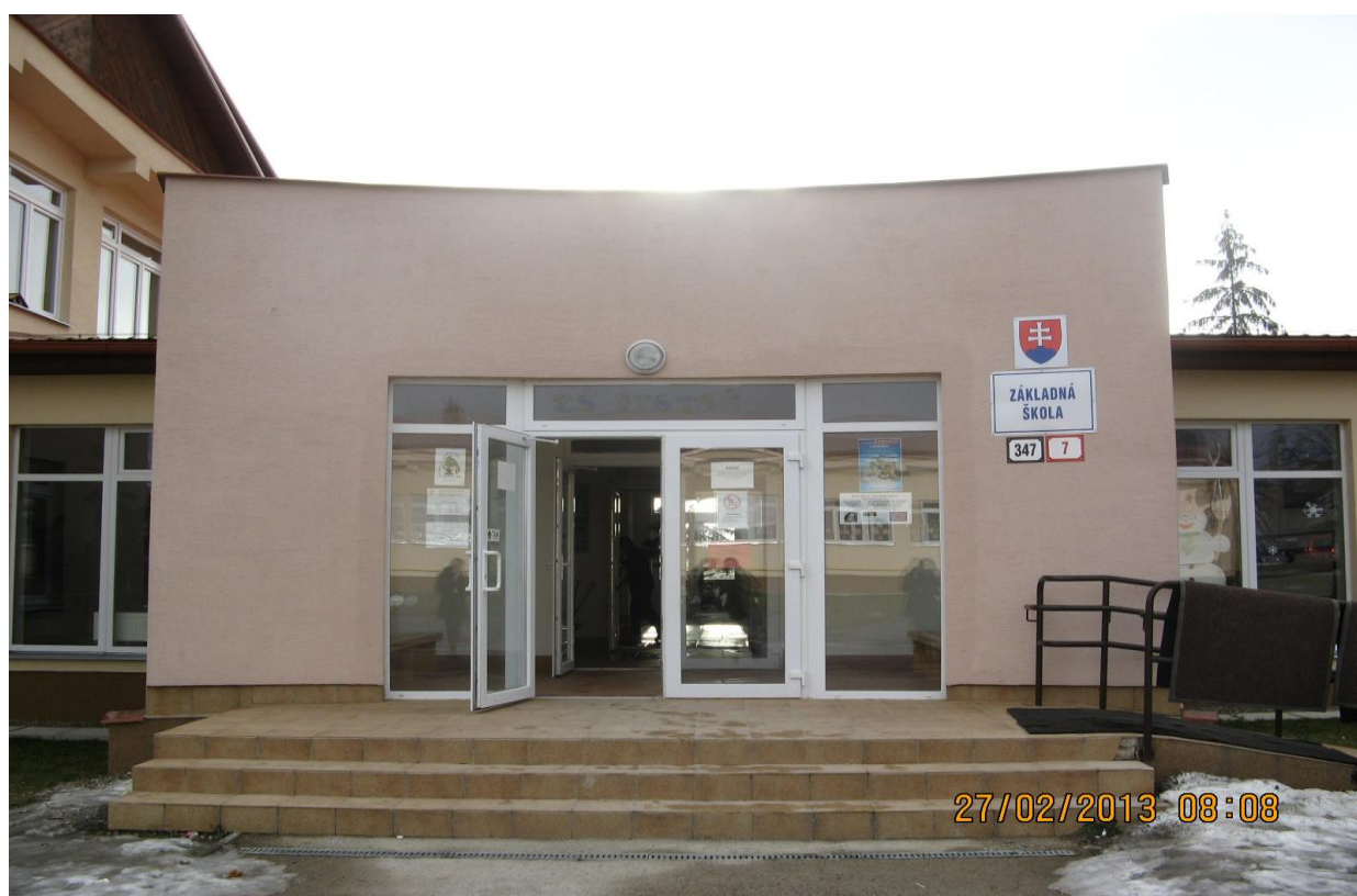
Hlavný vchod – budova ZŠ
