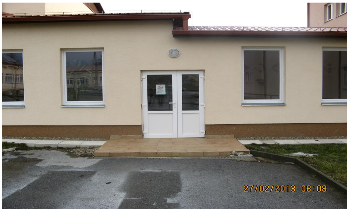
Vchod - Spojovacia chodba
