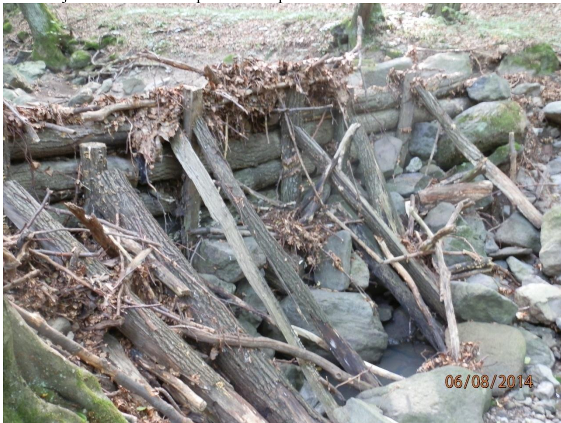
Skároš – jednoduchá drevená prehrádzka spevnená kameňmi
