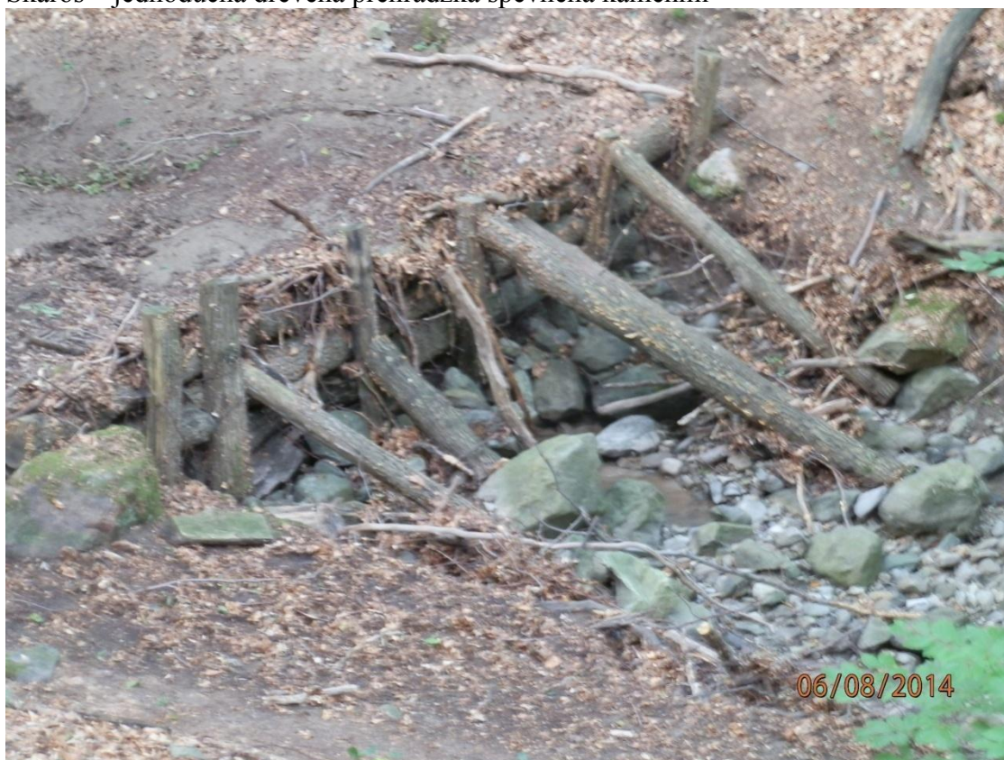
Skároš – jednoduchá drevená prehrádzka spevnená kameňmi
