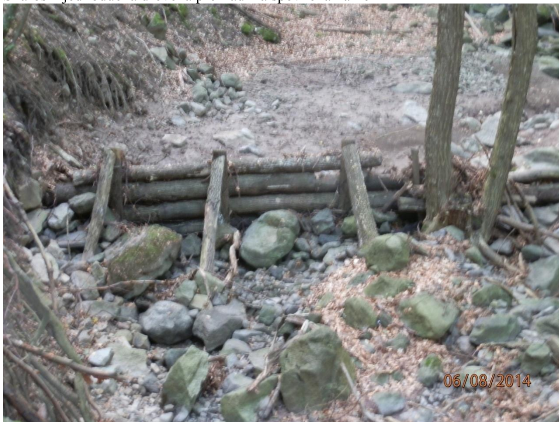
Skároš – jednoduchá drevená prehrádzka spevnená kameňmi
