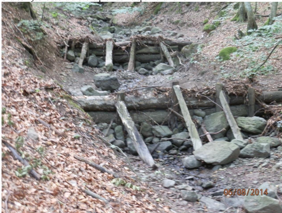
Skároš – jednoduchá drevená prehrádzka spevnená kameňmi
