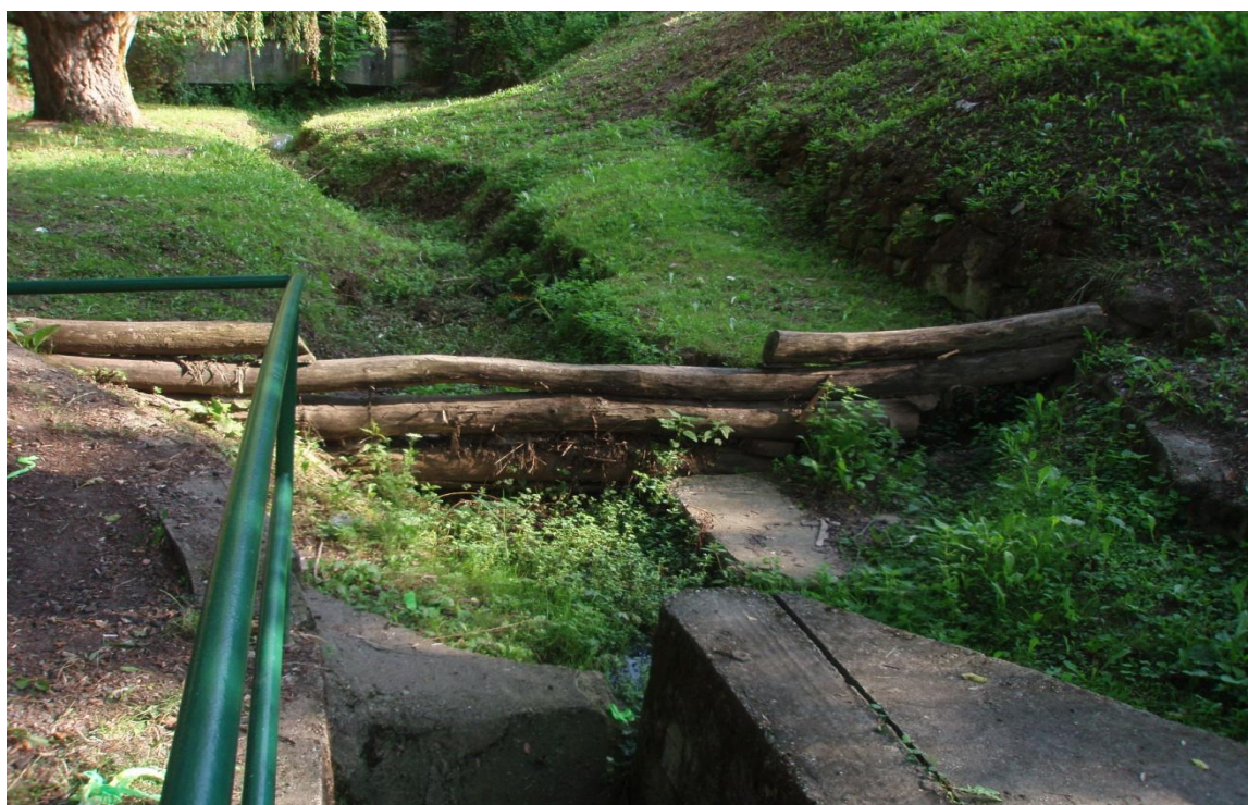
Obrázok č. 2 - Prehrádzka z výrezov drevnej guľatiny
