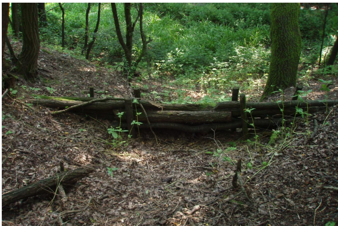
Obrázok č. 1 - Prehrádzka z výrezov drevnej guľatiny
