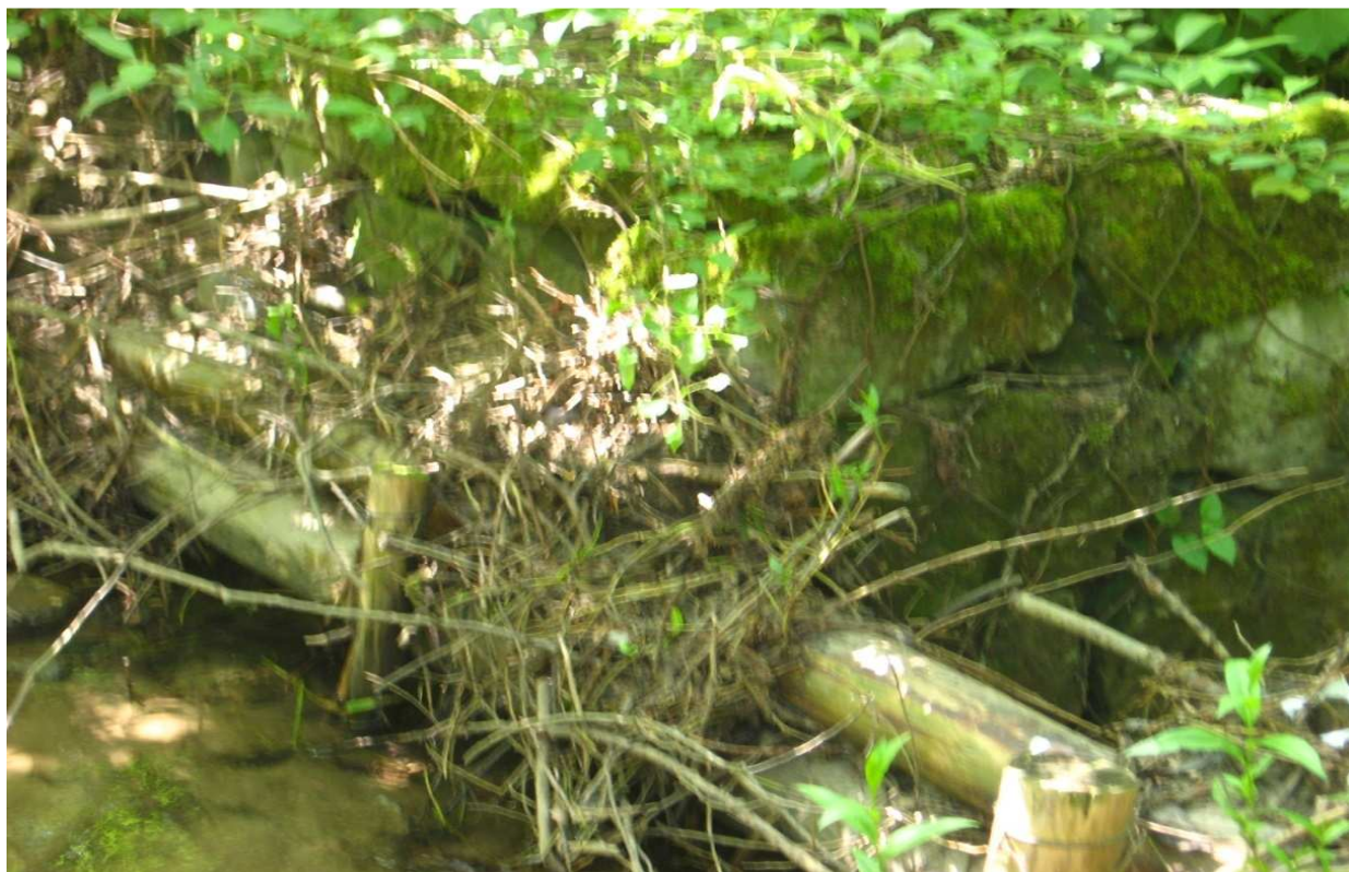
Rekonštrukcia kamennej hrádze predradením drevenej – lokalita 11 – Horná Biesová
