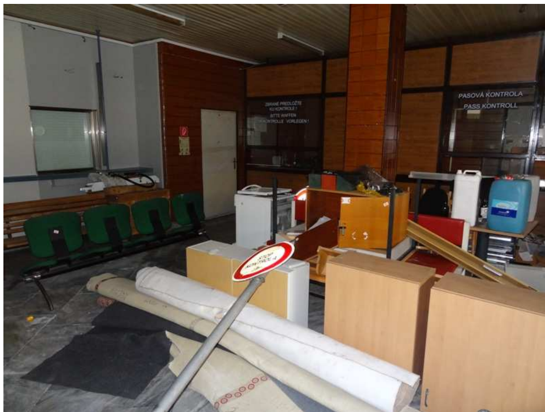
obr. č. 20 Vnútorne priestory budovy bývalej pasovej a colnej kontroly
