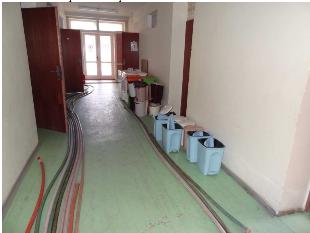
obr. č.6 Interiér nepoužívaného pavilónu B – uskladnenie rozličného materiálu
