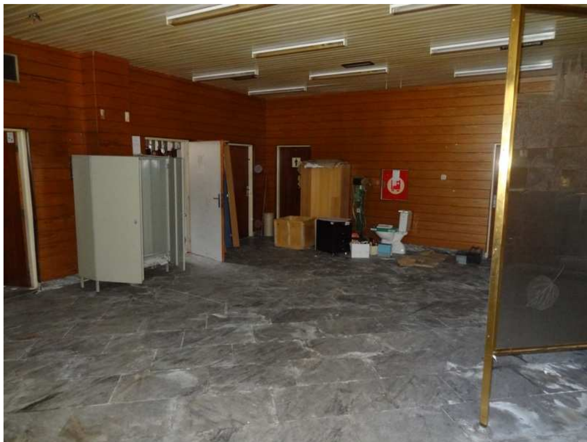
obr. č. 22 Vnútorne priestory budovy bývalej pasovej a colnej kontroly
