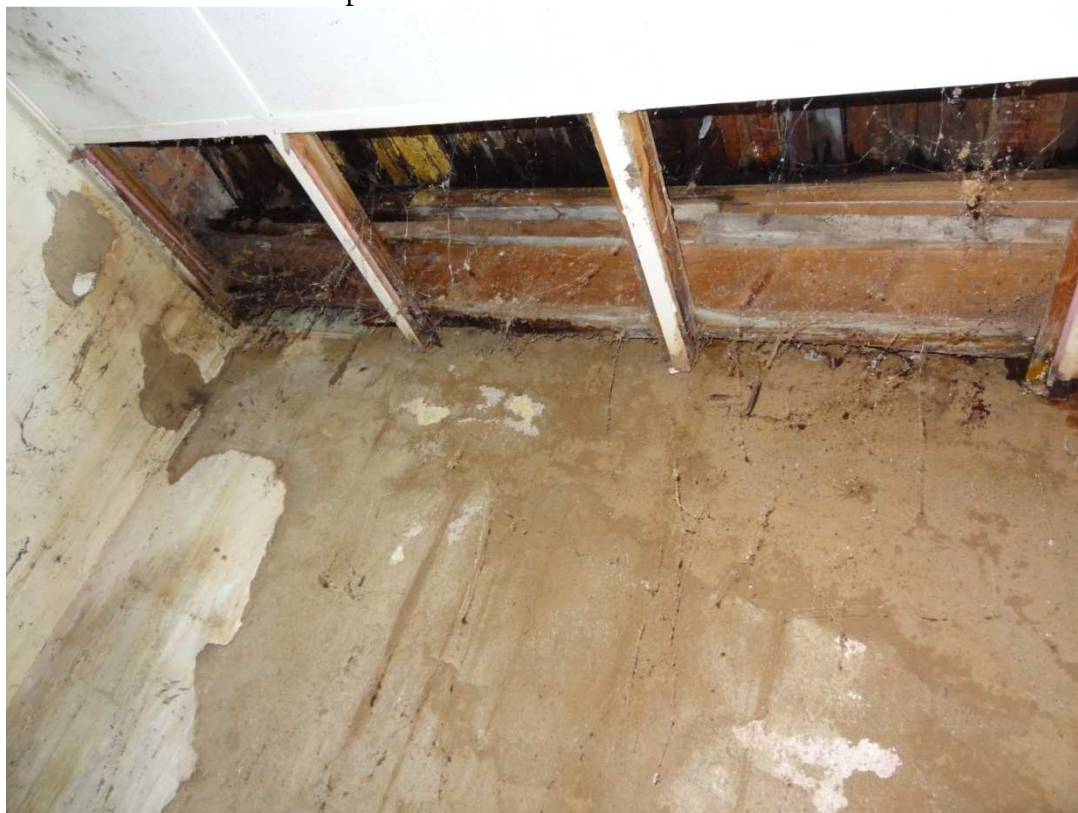
obr. č. 8 Hospodárska miestnosť pod terasou - strop
