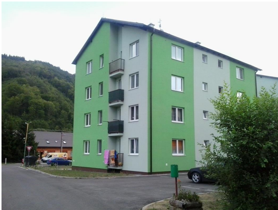
Bytový dom č. 274 – 16 bytových jednotiek – bočná a zadná strana
